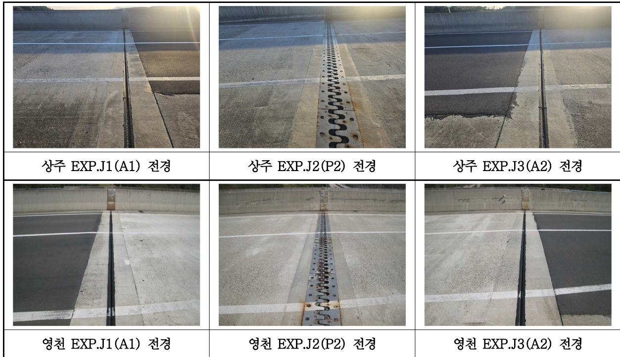
【사진 25.3.16】 신축이음장치 전경
