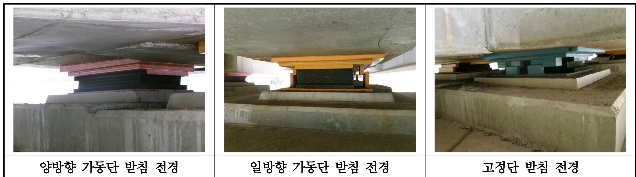
【사진 25.3.12】 교량받침 전경
