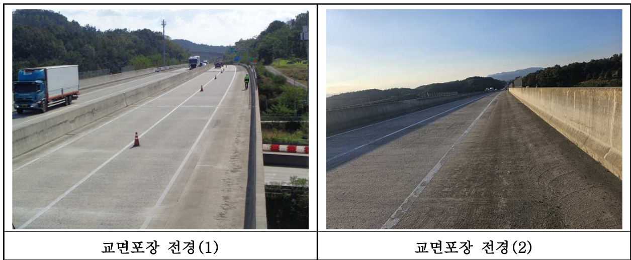
【사진 25.3.19】 교면포장 전경
