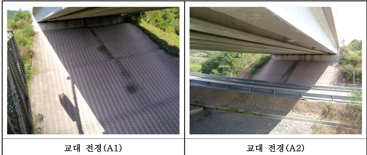
【사진 25.3.8】 교대 전경
