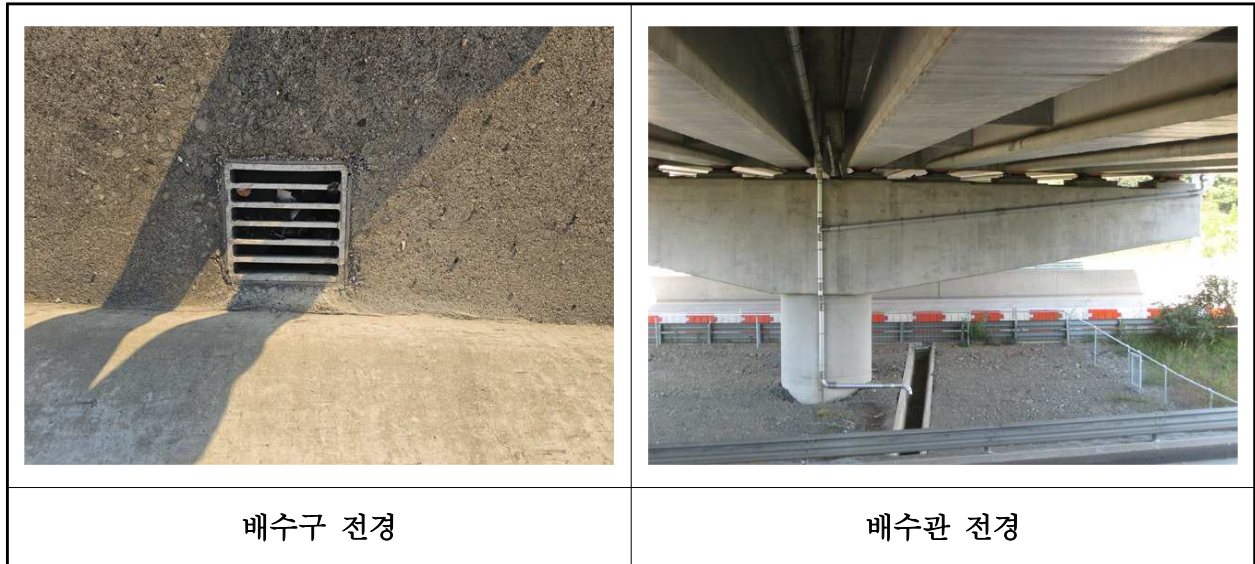
【사진 25.3.21】 배수시설 전경
