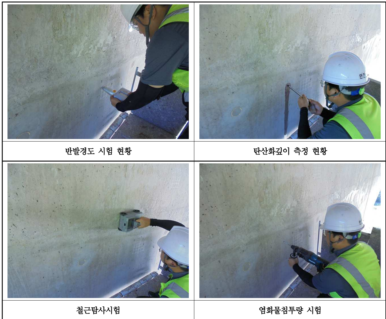
【사진 25.4.1】 콘크리트 내구성조사 현황
